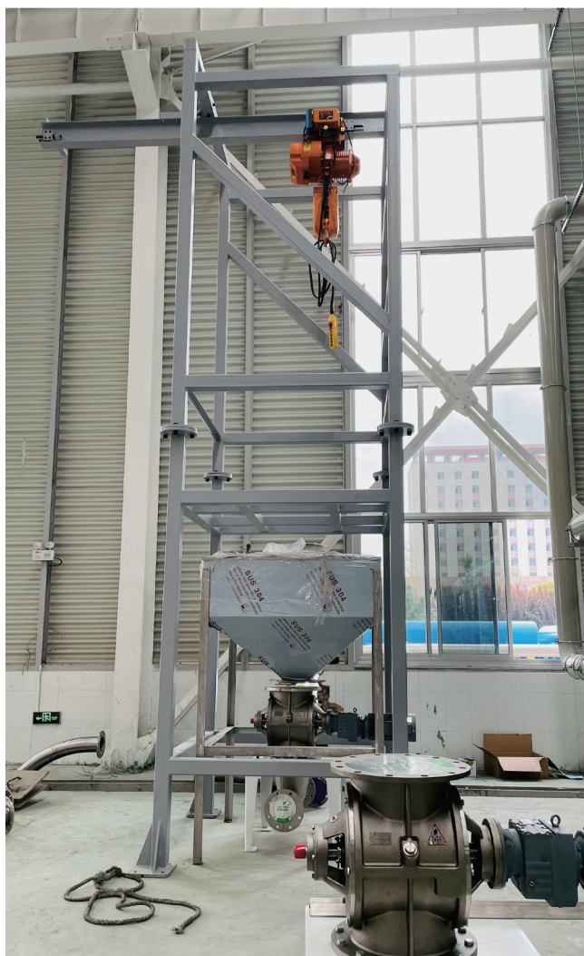
山东项目现场照片 On site picture
