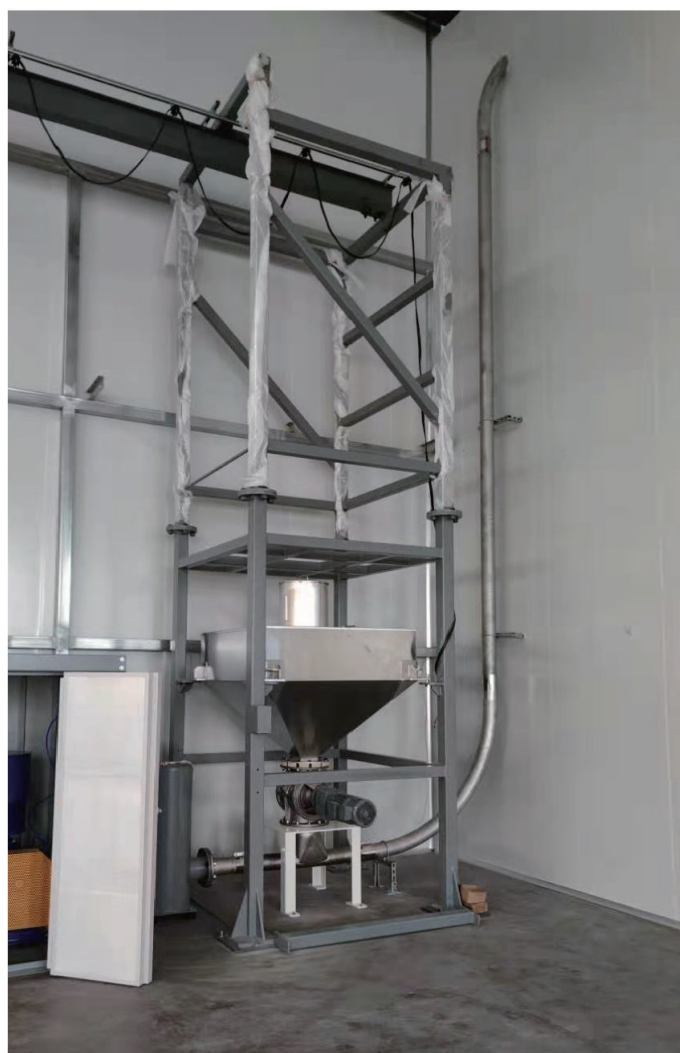
上海项目现场照片 On site picture
