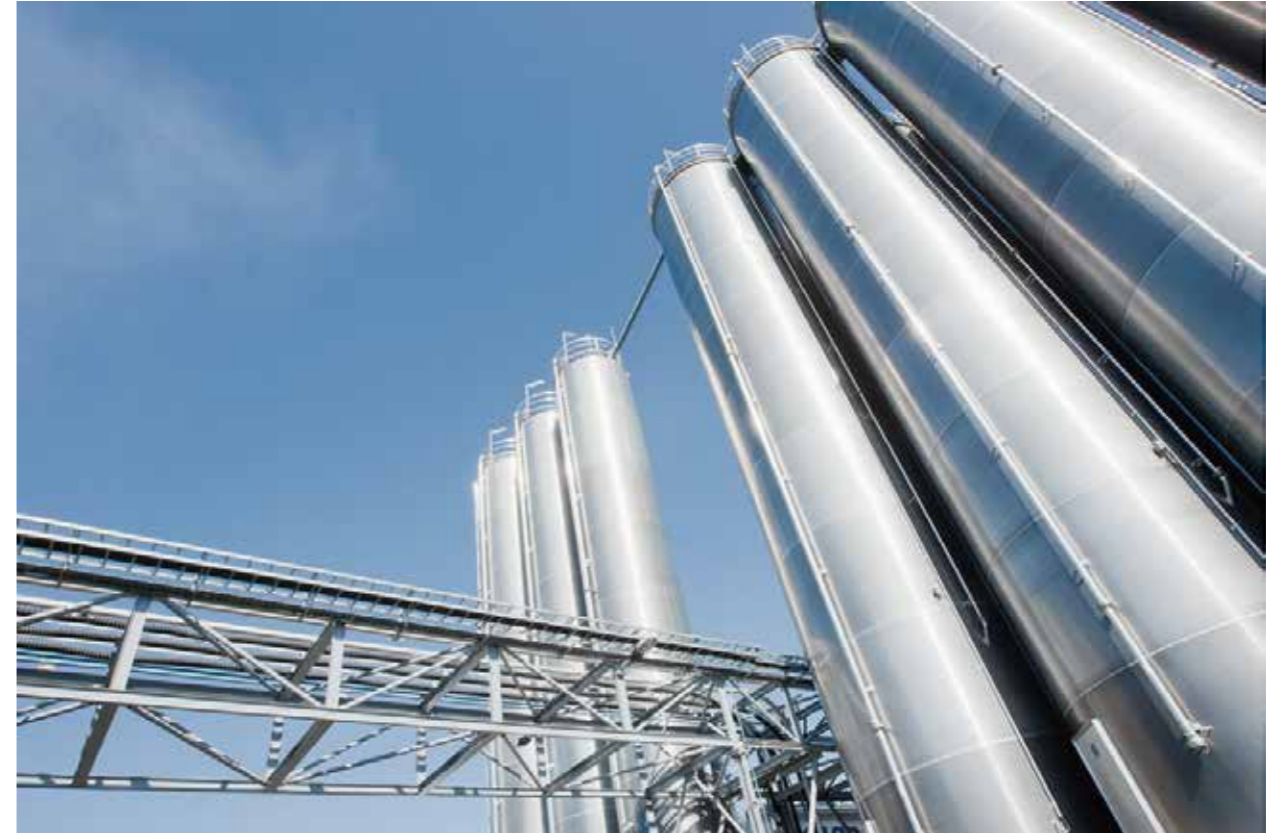
普通储料仓 Storage Silo
